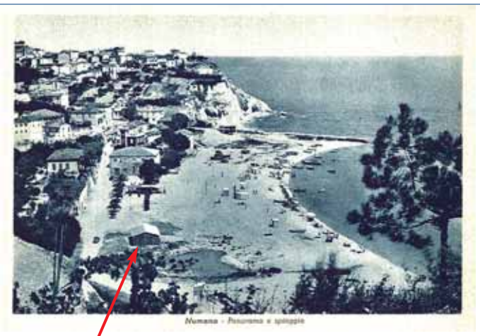
Il primo Cantiere Jurini
